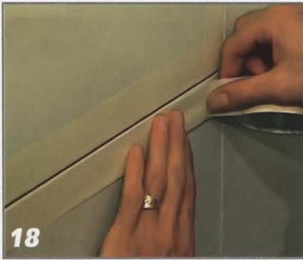
18 Малярной лентой шириной 20-30 мм оклеивают зоны вокруг технологического шва по периметру дверцы.
