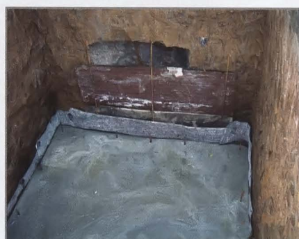
Устройство дна септика. На дно котлована укладывают слой рубероида, загибы которого не дадут «цементному молочку» впитаться в грунт, а затем укладывают арматуру и заливают бетон.
