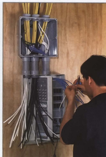
Провода из всех помещений дома подведены к коммутационной панели — в ней установлены модули, которые распределяют управляющие сигналы по помещениям.
