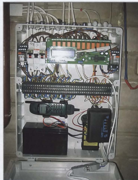
Доработанный электронный блок с GSM-сигнализацией
