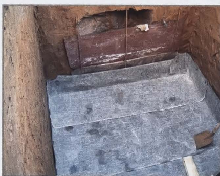
Устройство дна септика. На дно котлована укладывают слой рубероида, загибы которого не дадут «цементному молочку» впитаться в грунт, а затем укладывают арматуру и заливают бетон.
