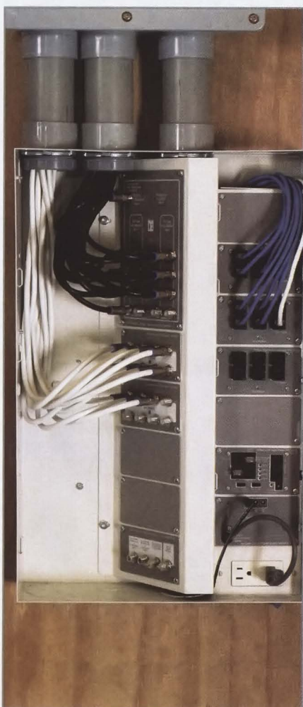
Переключить направление передачи данных или видеосигнала можно простой переборкой разъемов.
