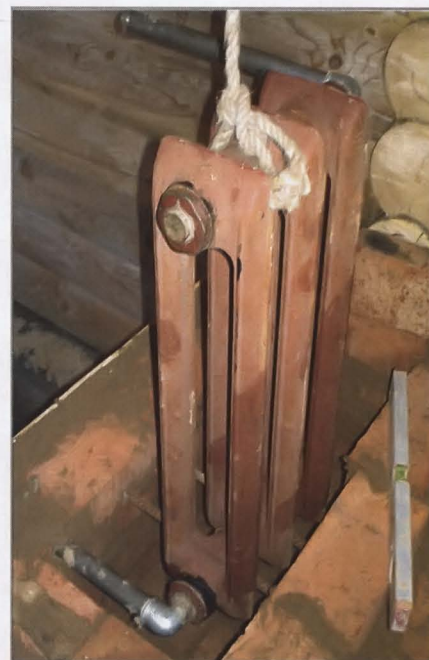
Котёл установлен на отрезки арматуры. На время работы его можно подвесить на верёвке, прикреплённой к балке перекрытия.
