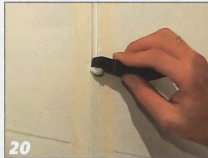
20 Излишки герметика сразу удаляют эластичным шпателем.
