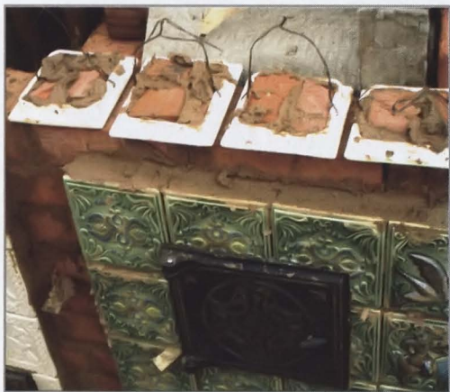
Изразцы, подготовленные для монтажа.
