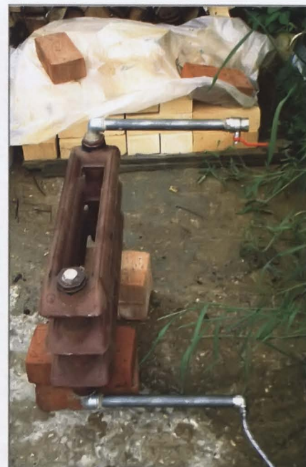
Для опрессовки котла можно использовать домашнюю насосную станцию.
