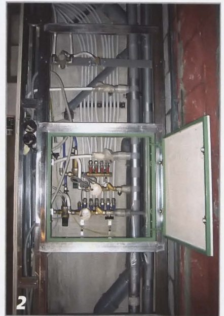
Для свободного доступа ко всем приборам, установленным в этом коробе, вполне достаточно иметь проём размером примерно 50x60 см.
