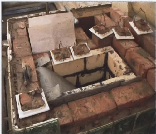
Изразцы монтируем в соответствии с утверждённой схемой.
