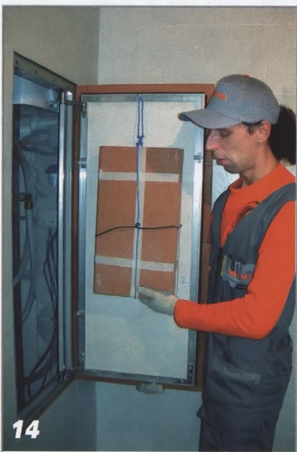
14 Для средних и больших люков перед наклеиванием плитки необходимо предварительно нагрузить дверцу.
