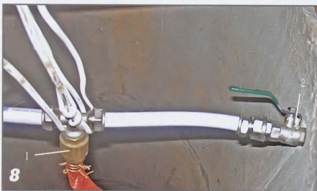
Первоначальный узел разбора воды из колодца: 1 — обратный клапан; 2 — наружный кран.
