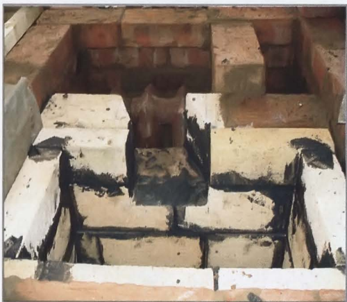
Горячие газы из топki поступают в камеру для котла.
