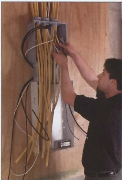
Провода из всех помещений дома подведены к коммутационной панели — в ней установлены модули, которые распределяют управляющие сигналы по помещениям.
