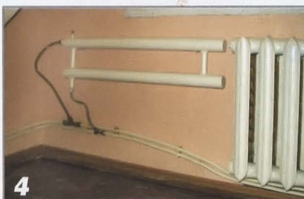
1. Отопительный котел. Наверху, на холодильнике — расширительный бачок. 2. Насос Willo Z15 и сетчатый фильтр. 3. Лежак из кухни через стену уходит в комнату. 4. Регистр подключен к лежаку гибкими шлангами. 5,6. Установленные самодельные регистры не портят интерьера комнаты.
