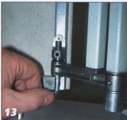
13 Чтобы иметь возможность точно отрегулировать положение дверцы по высоте, в комплект каждого люка входит специальный торцевой шестигранный ключ.
