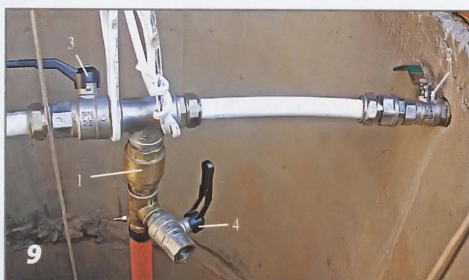
Узел разбора воды с дополнительной функцией осеннего водоснабжения: 1 — обратный клапан; 2 — наружный кран; 3 — кран отсечения летнего водопровода; 4 — кран для продувки обратного клапана.
