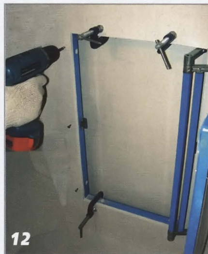
Люк с открытой дверцей вставляют в проём, временно фиксируют струбцинами и крепят раму люка к обшивке саморезами.
