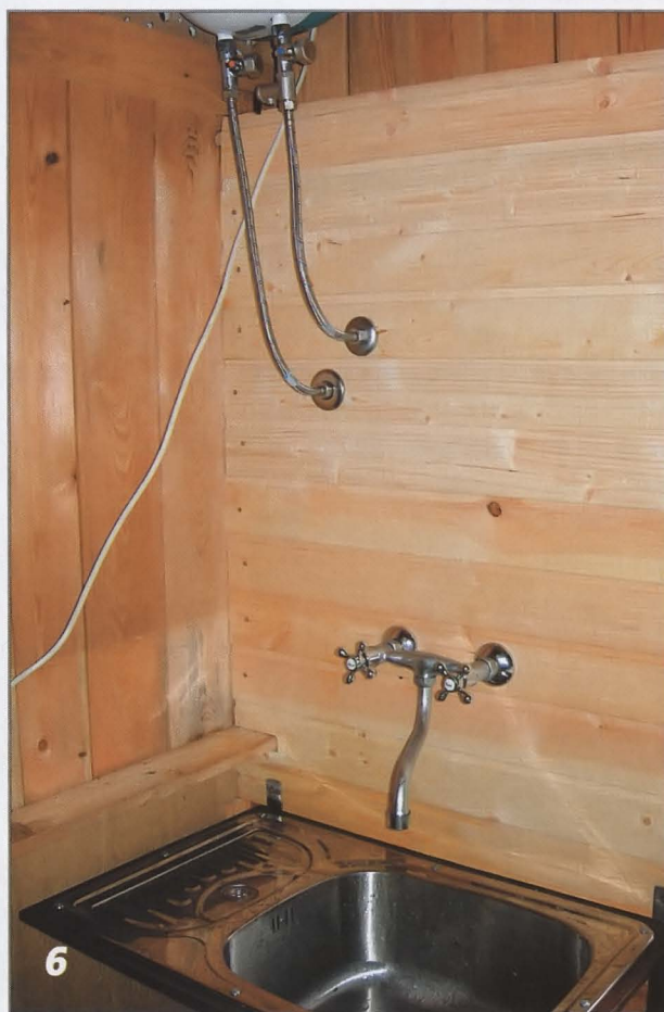
Внутренняя разводка в доме частично спрятана за вагонкой.
