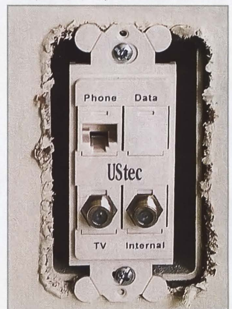
В этом техническом порту есть разъёмы как для телефона, так и для видеосигнала.
