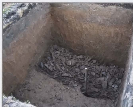
Строительство септика начинают с земляных работ.
