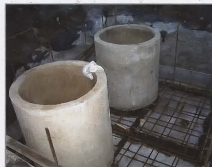
Ответственный этап работы — армирование перекрытия и установка колец горловины.
