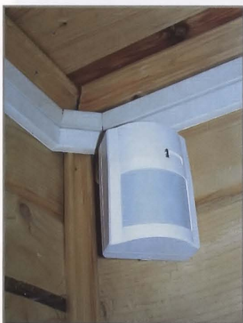
В приемное окно датчика движения не должны попадать солнечные лучи.
