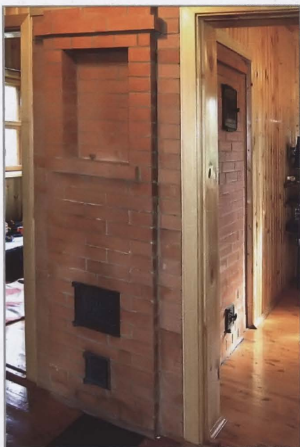
Большие боковые зеркала отопительной голландки обращены в смежные спальни, а топка расположена со стороны прихожей.
