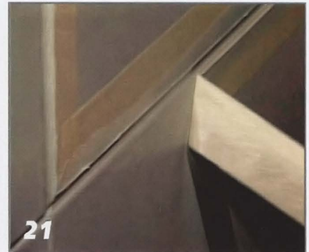
21 Не дожидаясь «подсыхания» герметика, малярную ленту снимают, начиная с внешней стороны.
