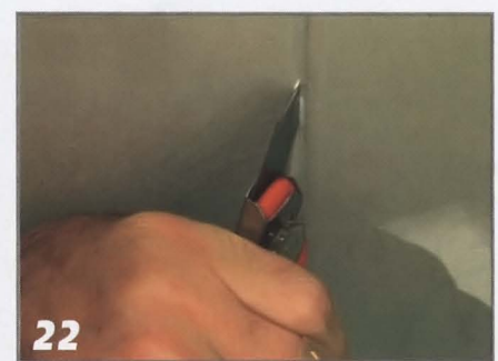
22 Через двое суток, когда герметик полностью высохнет, его прорезают на всю глубину под углом 45°.
