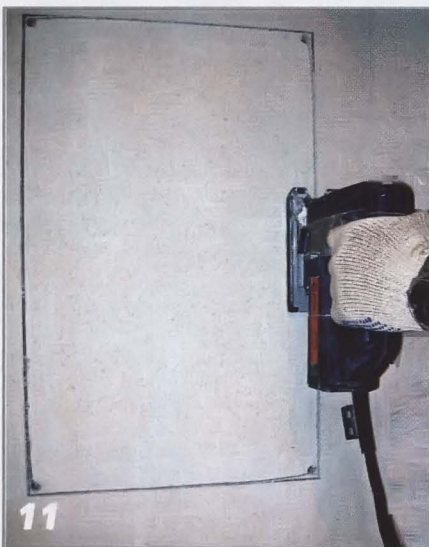
...и вырезают его электролобзиком.
