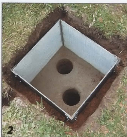
Этапы устройства кессона для слива воды
