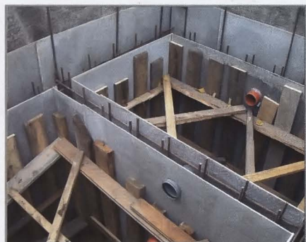
Монтаж несъёмной опалубки из асбоцементных плит. В опалубке закрепляют воздушную и переливную трубы, а также оставляют отверстия для подводящего и отводящего трубопроводов.
