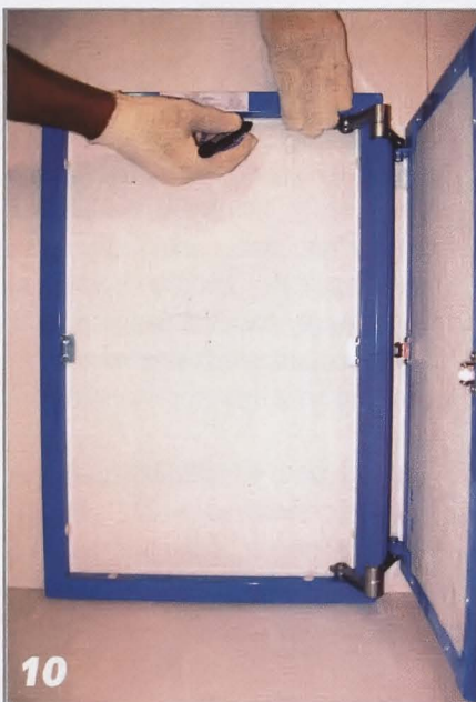
После сборки и обшивки каркаса в заранее отмеченном месте размечают отверстие под люк...
