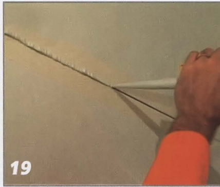
19 Оставленную щель заполняют на всю глубину силиконовым герметиком так, чтобы он немного возвышался над уровнем малярной ленты.
