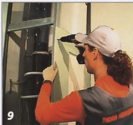
Каркас обшивают панелями из влагостойкого гипсокартона (ГКЛВ) толщиной 12,5 мм.
